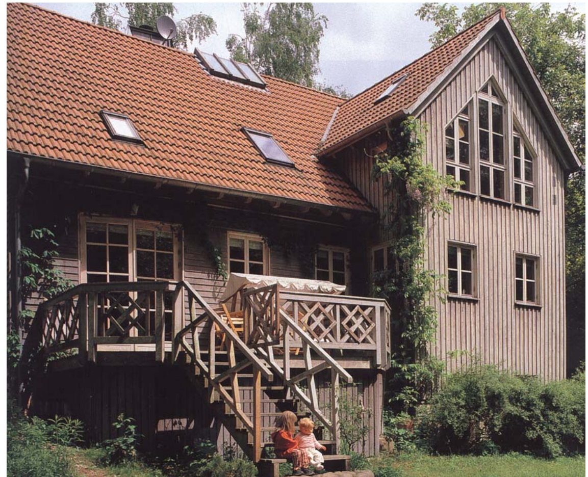
Gartenansicht mit Veranda
