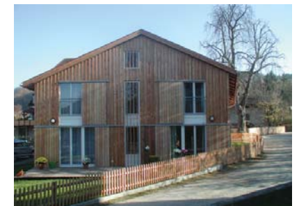
Die Rückseite des sanierten Bauernhofes
