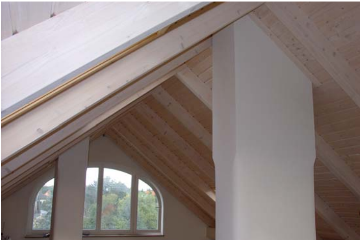
[Abb. 1a] Holzschalung mit Lasur/Kalkputz (Silikat-Anstrich) Dachausbau Berlin-Reinickendorf
