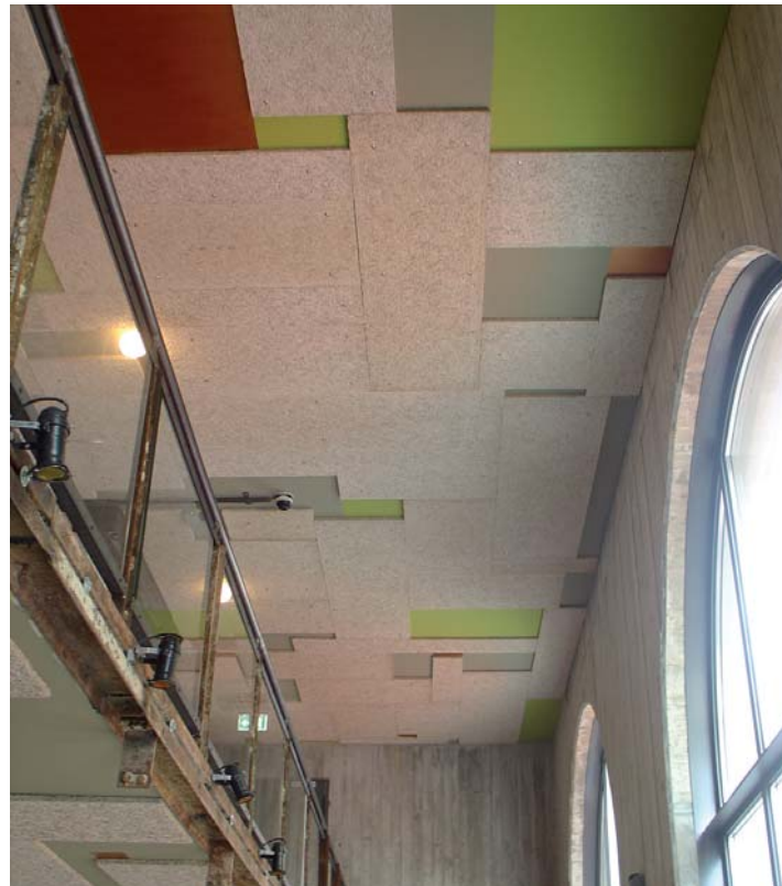
[Abb. 1b] Magnesitgeb. Holzwolleleichtbauplatte/Farbanstrich/rauer Strukturbeton VIA Schankhalle Pfefferberg Berlin-Prenzlauer Berg
