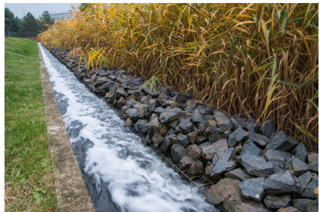
Retentionsbodenfilter Adlershof (Foto: Andreas Süß)
