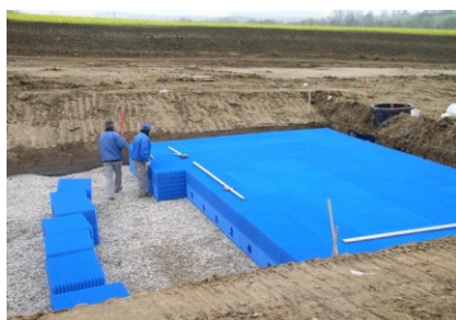
Bau einer Füllkörperrigole (Foto: Sieker)
