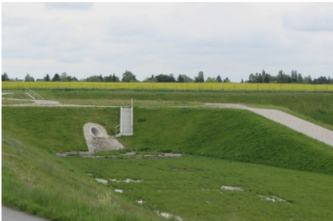
Regenrückhaltebecken im Business Park Berlin-Bohnsdorf (Foto: BWB)
