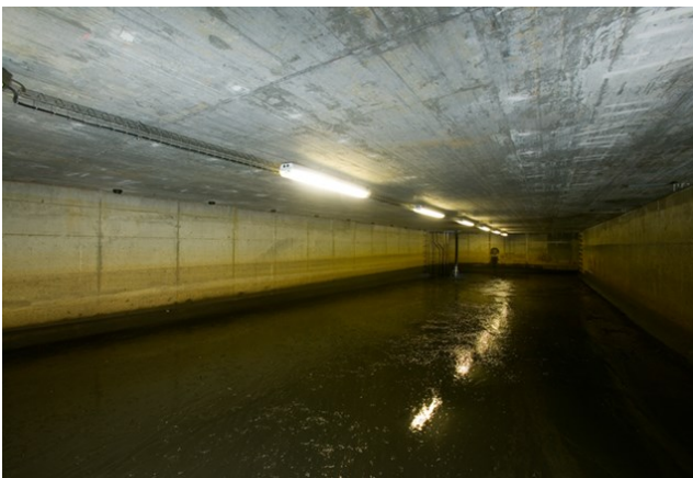
Regenklärbecken Schlierseeestrasse, Berlin-Köpenick (Foto: BWB)
