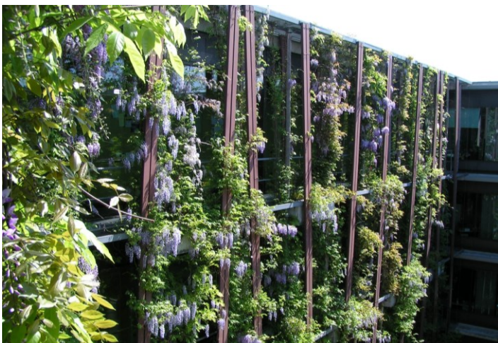
Systemgebundene Fassadenbegrünung in Kübeln, Institut für Physik in Berlin Adlershof (Foto: M. Schmidt); Sonderform mit Anstaubbewässerung und Kletterhilfe
