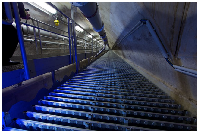
Schrägkläreranlage (Lamellenabscheider) am Fennsee (Foto: BWB)
